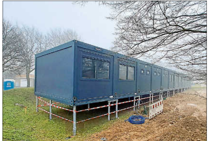
Die Containeranlage für das Kita-Provisorium WaldHöhle ist in den vergangenen Tagen aufgestellt worden.
