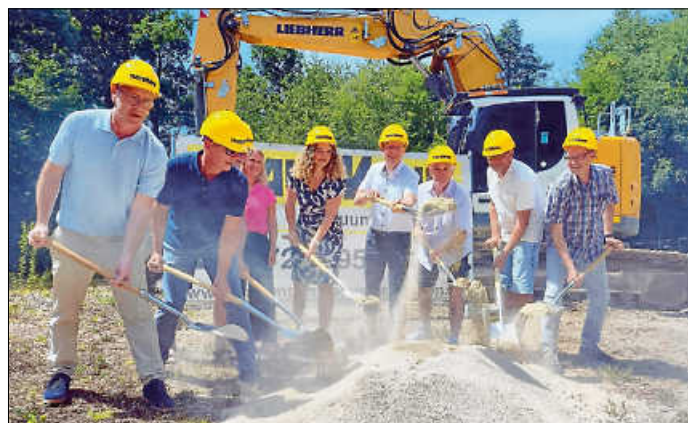
Es ist vollbracht: Vertreter aller Beteiligten freuen sich über den symbolischen ersten Spatenstich für den Neubau der Kita Etzenrot. Foto: Gemeinde Waldbronn
