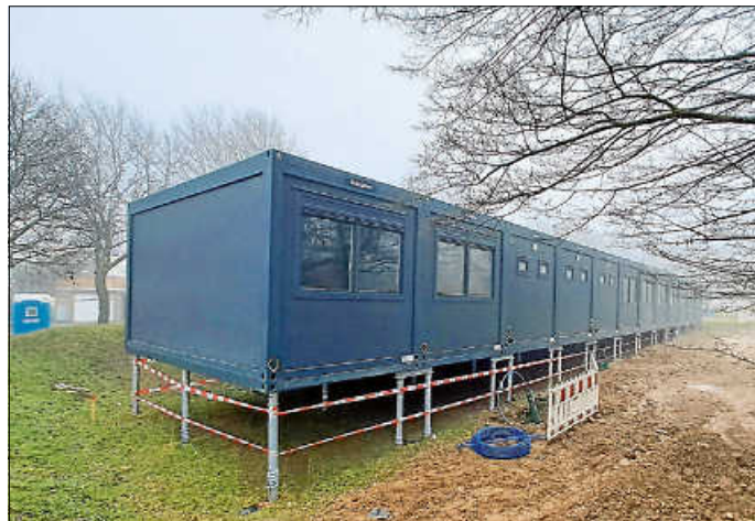
Die Containeranlage für das Kita-Provisorium WaldHöhle ist in den vergangenen Tagen aufgestellt worden.
