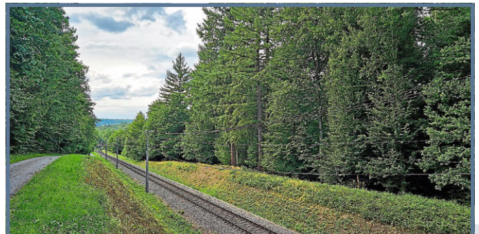
An der AVG-Linie werden während der Wartungsarbeiten einige Verkehrssicherungsarbeiten vorgenommen.
