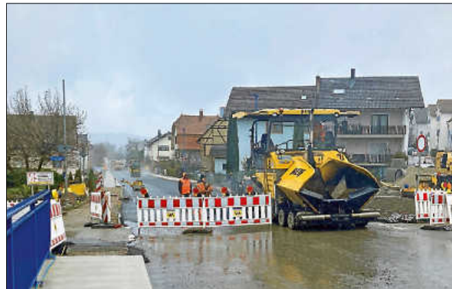
Asphaltarbeiten auf der Pforzheimer Straße.
