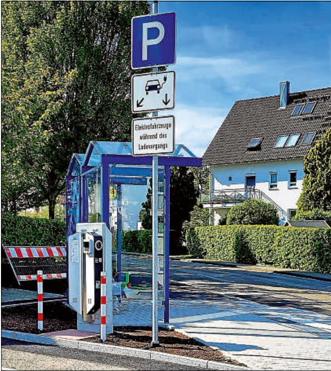
Die Bushaltestelle am Friedhof in Reichenbach ist barrierefrei ausgebaut worden. Eine neue E-Ladestation kam hinzu. Foto: Gemeinde Waldbronn
