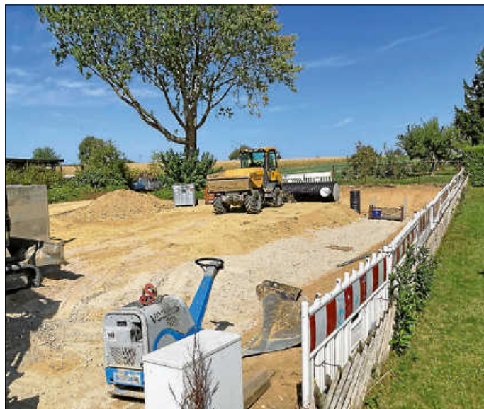
Regenrückhaltebecken an der Mannheimer Straße, Blickrichtung Norden. Foto: Gemeinde Waldbronn
