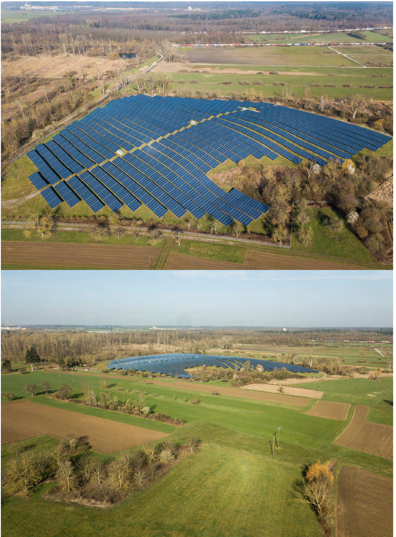
Photovoltaik-Freiflächenanlage auf dem alten Deponiegelände Stützel in Malsch
